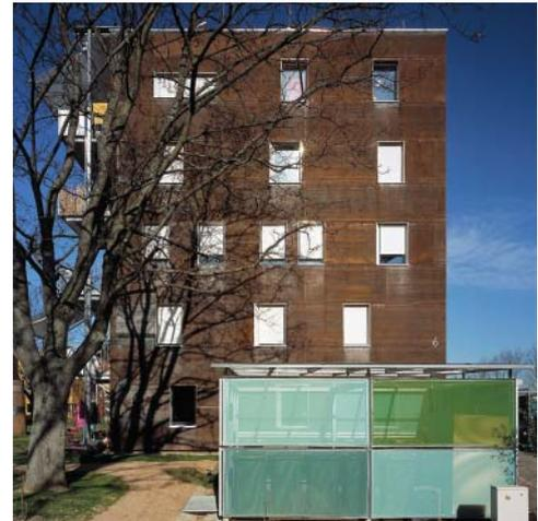
Bild 4.34: Ostfassade Haus 2 mit Stahlbekleidung
