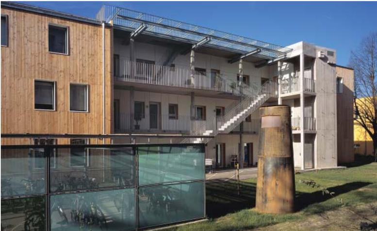
Bild 4.33: Treppenaufgang mit Laubengängen und Aufzugsturm auf der Nordseite
