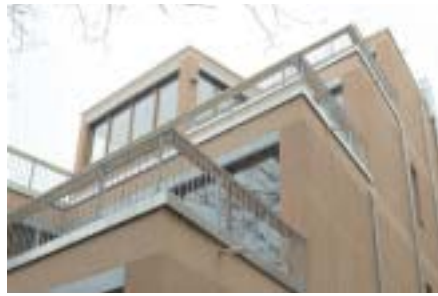
Ansicht mit Dachterrassen
